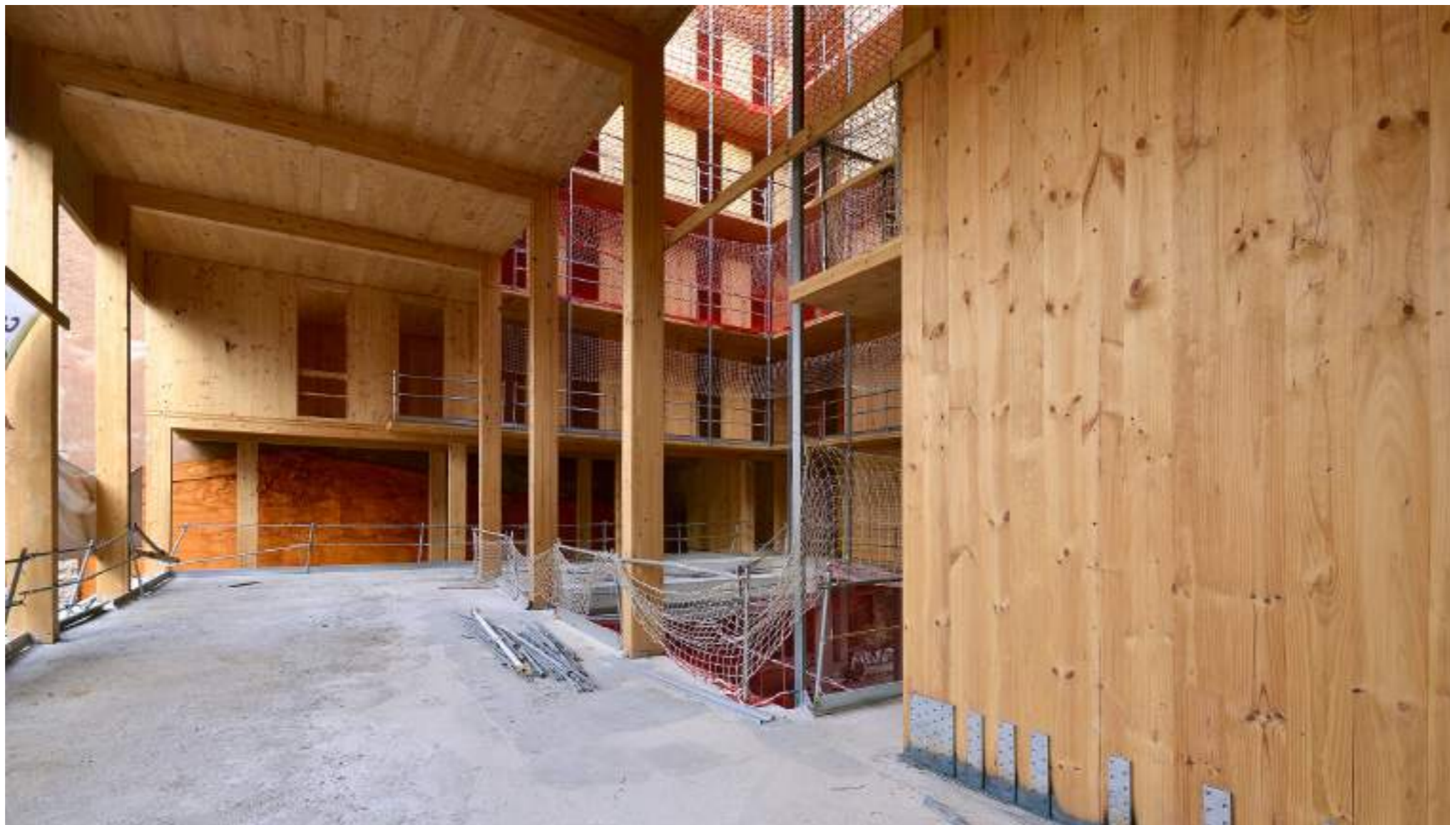
La Bordako obra, estatuko egurrezko eraikin altuena . La obra de La Borda, el edificio de madera más alto del estado
